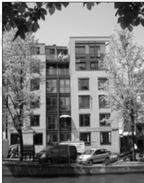
Ouderenwooncomplex 'Toren' aan de voet van de Wester
